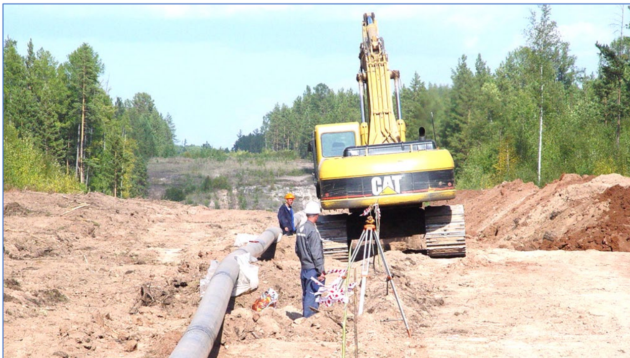
Строительство 1-ой нитки газопровода Братское ГКМ – Братск.
