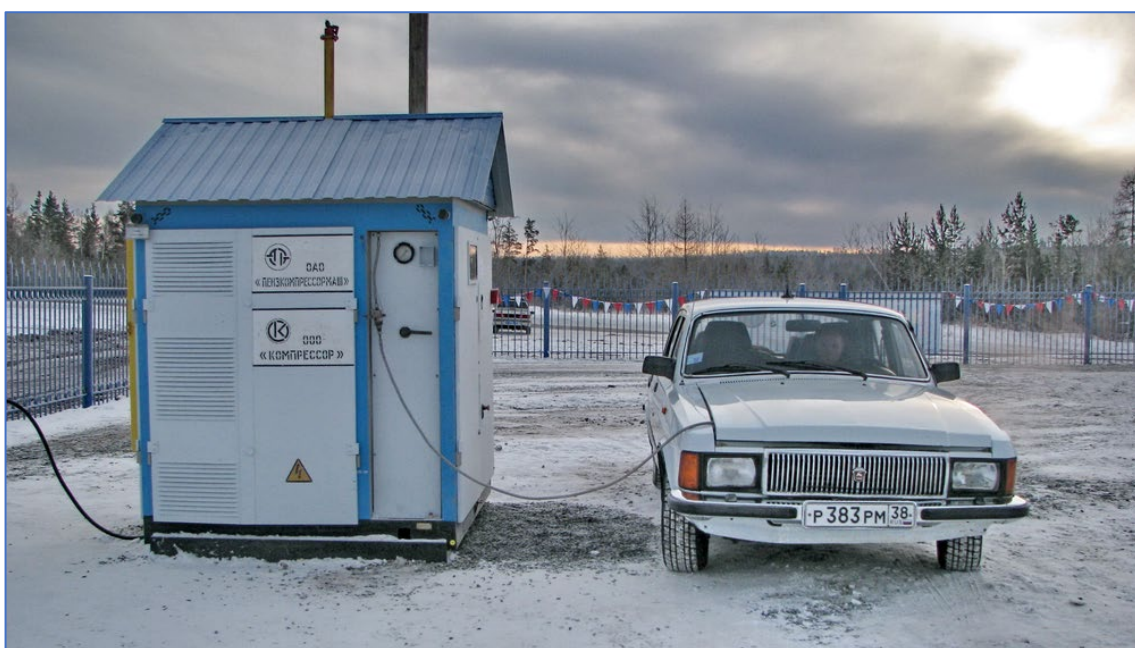
АГНКС-1 Братск, производительность 50 заправок в сутки. Оборудование ОАО «Пензкомпрессормаш».
