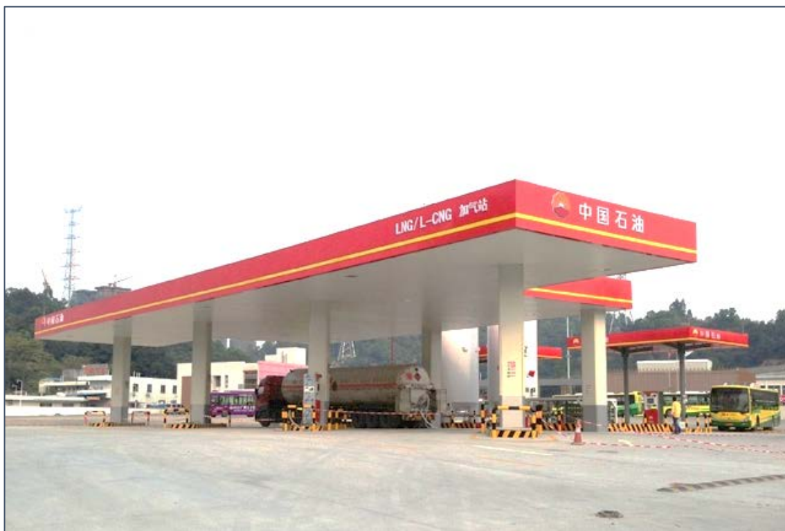
Станция СПГ/СКПГ в Китае
